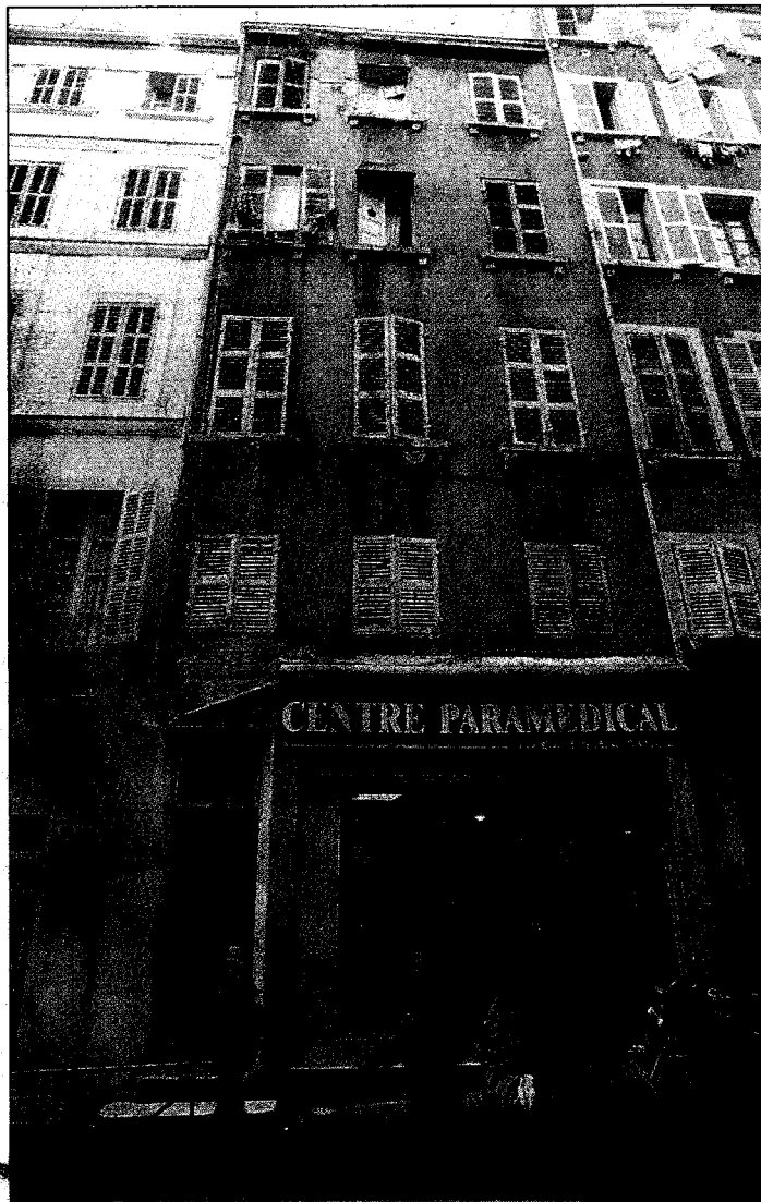
► Les riverains s'interrogent sur le lien existant entre la chute mortelle de Farouk et l'insalubrité de l'immeuble. / PH. VINCENT BEAUME
